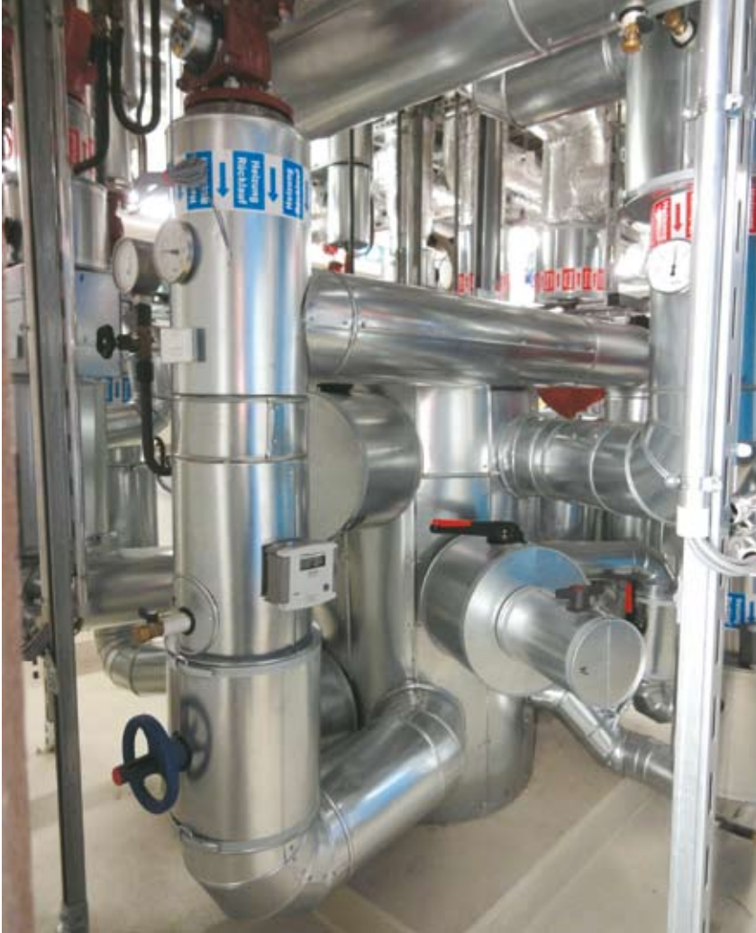
Resim 4. Üç kademeli bir Zortström ısı ve akış balanslama cihazı ile farklı sistem sıcaklıklarına sahip ısıtma devreleri beslenmektedir. 3 sıcaklık tabakası sayesinde yüksek sıcaklık ısıtma devrelerinden dönen ısıtma suyu düşük sıcaklık ısıtma devrelerinde giriş ısıtma suyu olarak kullanılmaktadır.
