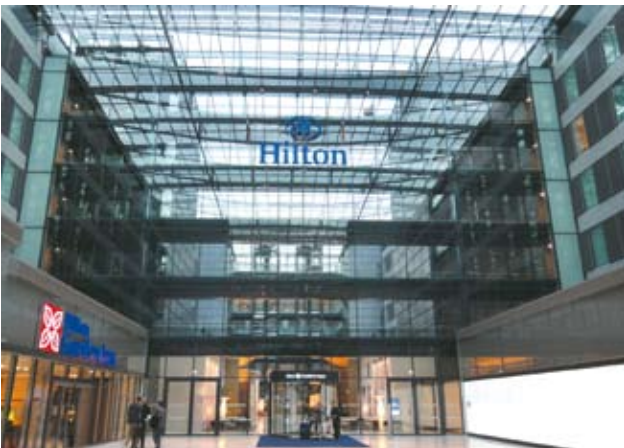
Resim 2. Bina yapısı ve cam cephe ısıtma ve soğutmada hızlı ve dinamik bir yük değişimine sebep olmaktadır.
