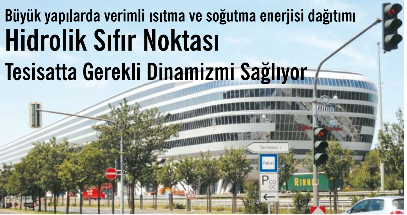
Resim 1. The Squire projesi mimari ve bina tekniği açısından bir şaheserdir. Bina alışlagelmiş yapılardan farklı olması ile etkileyici ve tesisat tekniği uygulaması açısından yüksek ve zor taleplere sahiptir.
