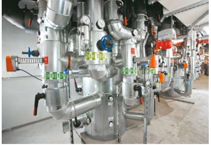
Resim 5. Sqaire projesinde Yapı Bölümü 1'in merkezi ısıtma tesisat daresinde kullanılan Zortström ısı ve akış balansı cihazı sayesinde ısıtma devrelerinde dengeli basınca ulaşılmaktadır.
