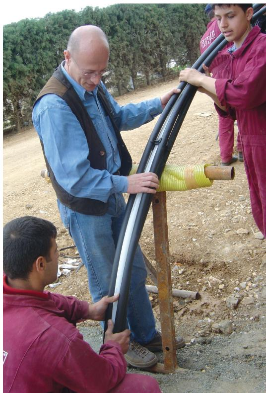
*Şekil 11. Çift U-borunun kuyuya yerleştirilmesi (3).*
