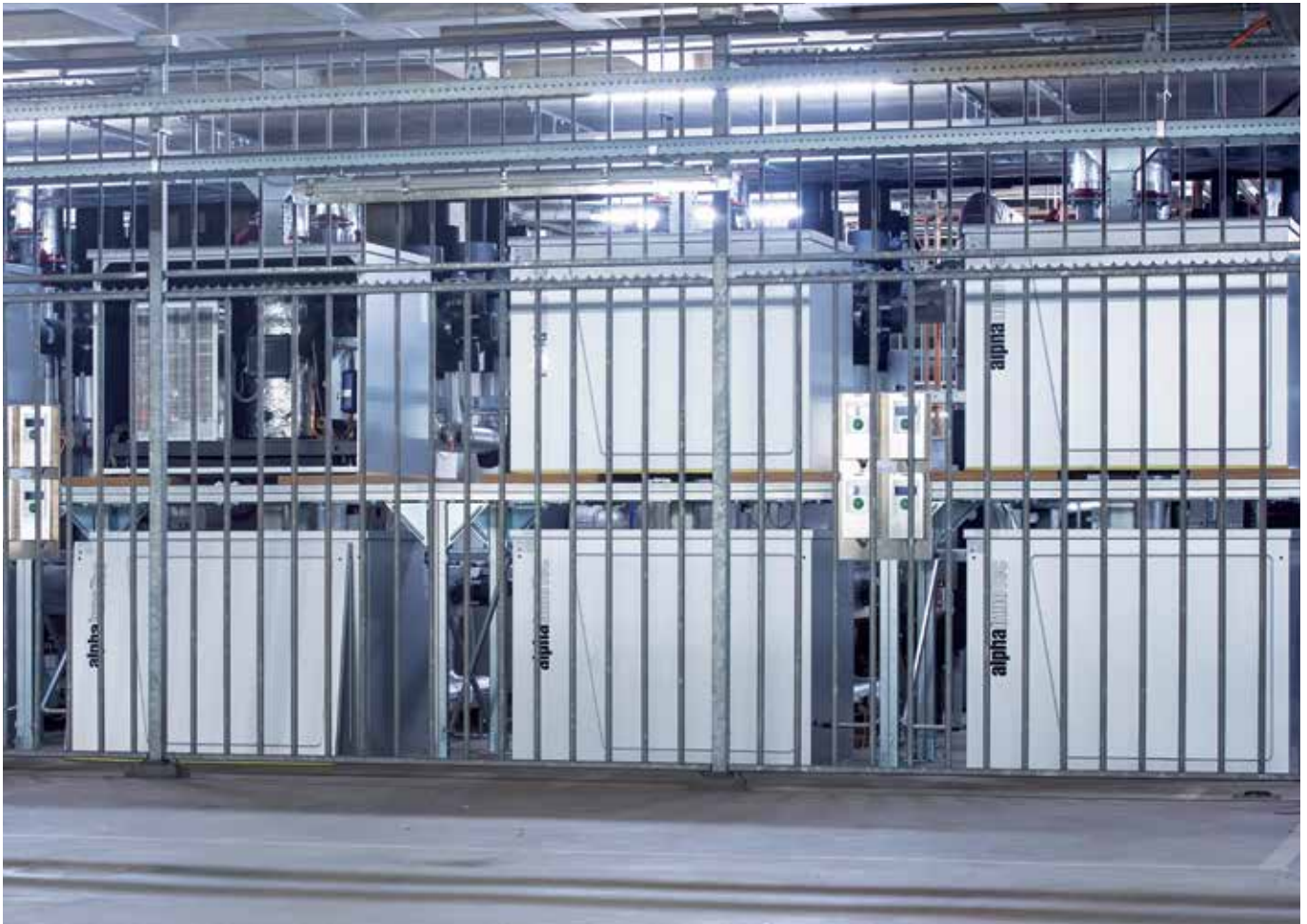
Oranje Nassau III kömür madeni (Hollanda) ve toprak kaynaklı ısı pompası örneği
