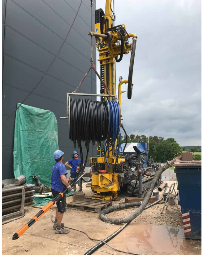
Jeotermal sondanın bir makara kullanılarak sondaj deliğine yerleştirilmesi. (Foto: Erdwärme plus)
