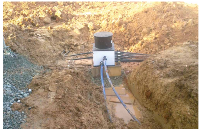
Bir dağıtım mili vasıtasıyla kolektör devrelerinin birleştirilmesi.(Foto: Erdwärme plus)
