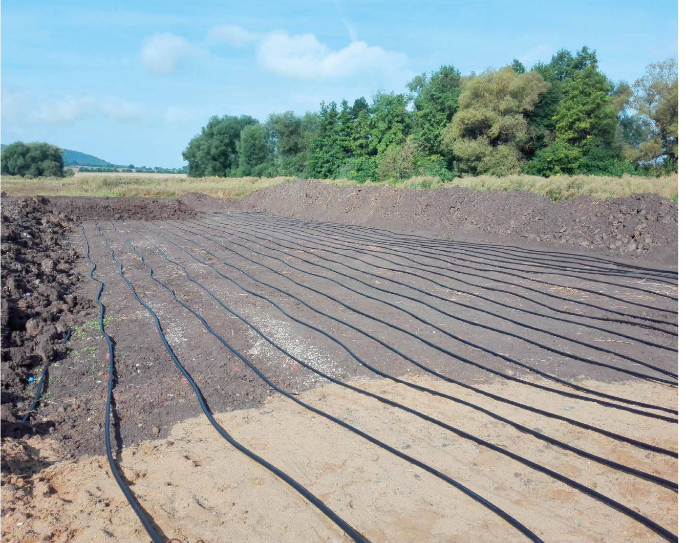
Açık bir kazıda kolektör devreleri: standart kolektör PE = 32 mm.
