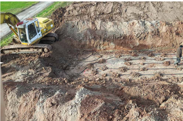
Ekskavatör ile kolektör sisteminin montajı ve doldurulması.(Foto: Fa. Günthner)
